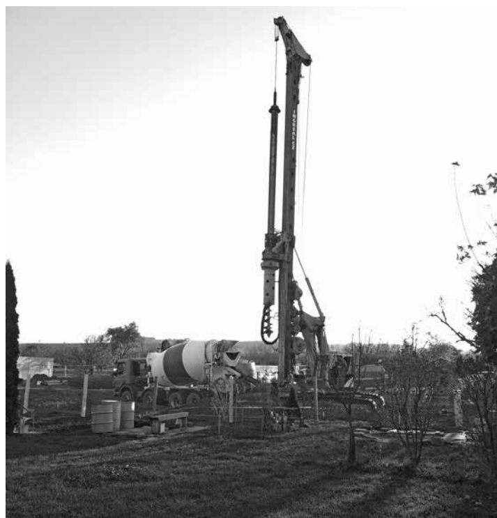
Na Komunitním domě pro seniory Kvasice se už pracuje.
