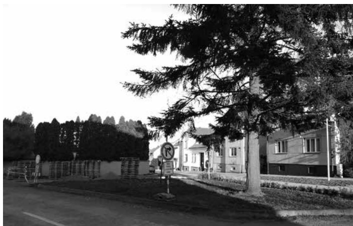
Proběhla rekonstrukce povrchu ulice Zahradní a Bělovská.
