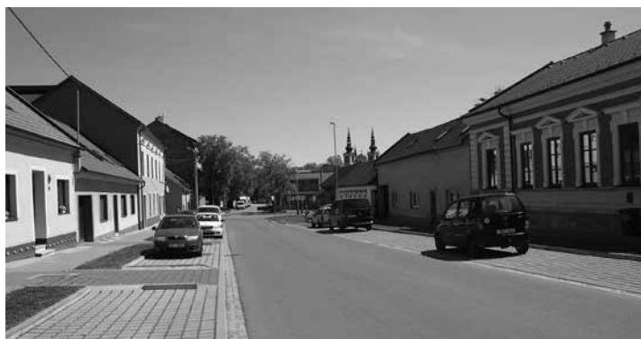
Horní ulice po rekonstrukci
